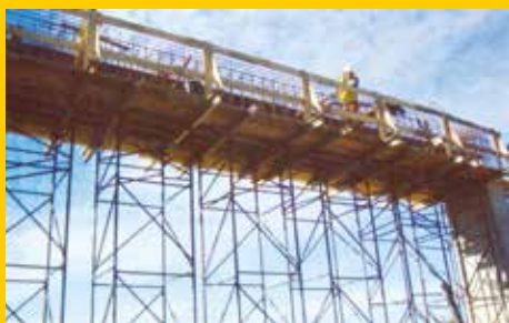
By-pass Aeropuerto Internacional de Carrasco
