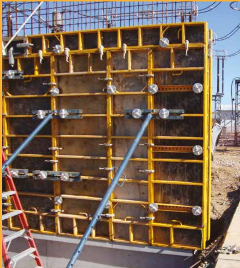
Muros con Paneles ATK60 en la sub-estación eléctrica de UTE en San Carlos. Empresa constructora: UTE
