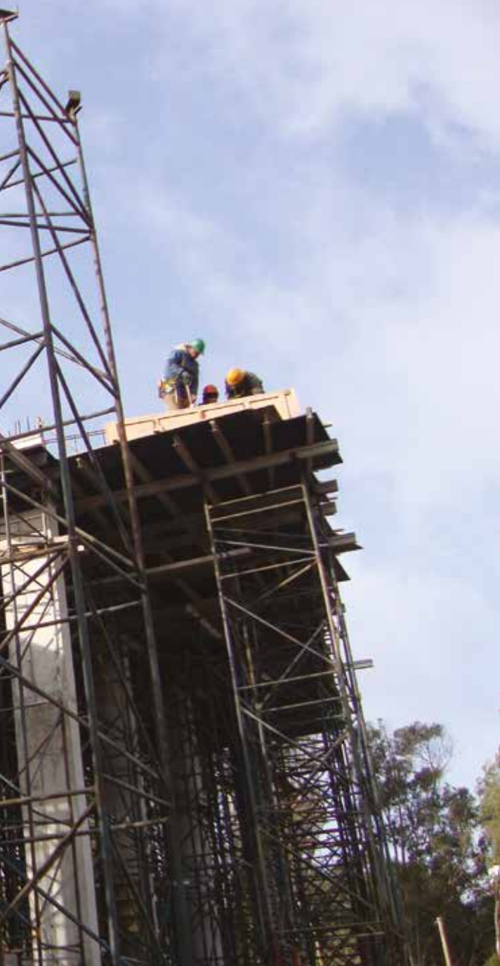
Torre One, Punta del Este, Maldonado. Encofrado en doble altura Empresa Constructora: TECSA, Ingeniería y Construcción
