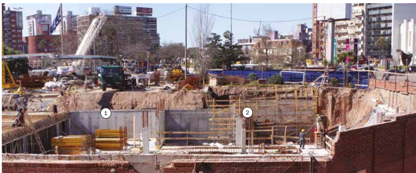
1 - Muro de contención en ampliación de Shopping de Tres Cruces con Paneles ATK60. Empresa Constructora: Stiler S.A. 2 - Pilares con Paneles ATK60 en ampliación del Shopping Tres Cruces. Empresa Constructora: Stiler S.A.
