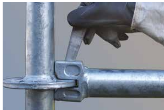
La cuña del travesaño se encastra en la roseta fácilmente
