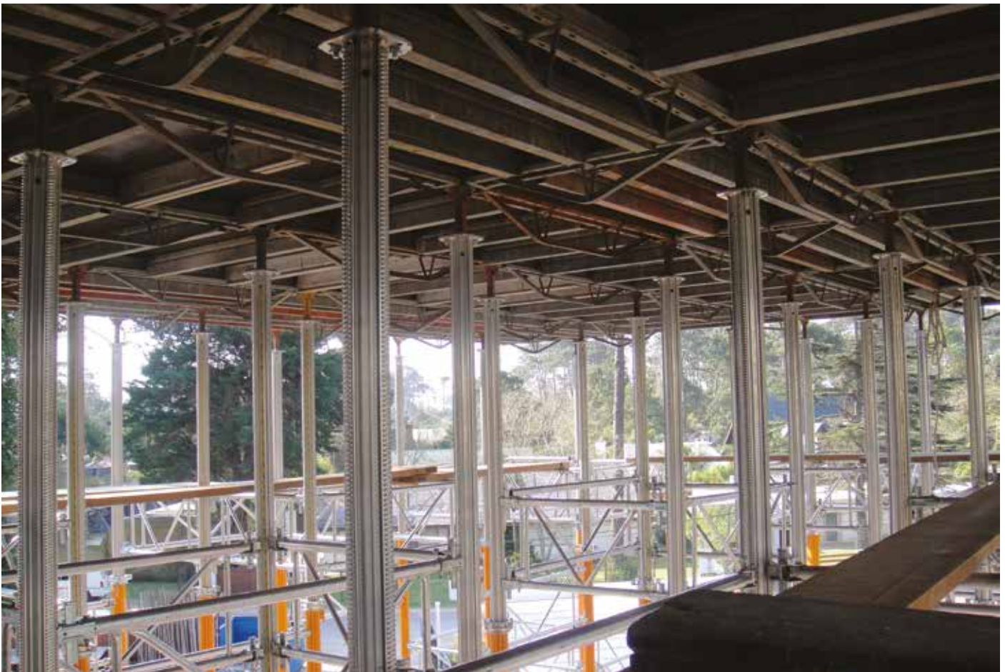
Obras de ampliación del Sanatorio Cantegril en Maldonado (AMECOM). Apuntalamiento encofrado con Superdeck.
