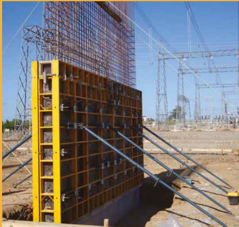
Muros con Paneles ATK60 en la sub-estación eléctrica de UTE en San Carlos. Empresa constructora: UTE
