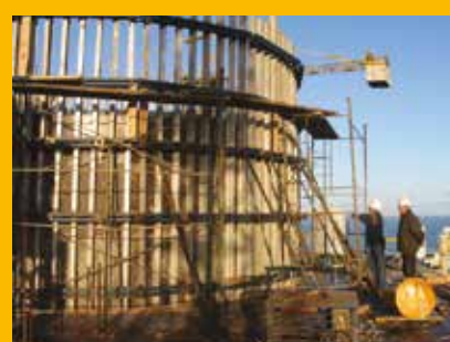
Vigas de Aluminio montadas sobre "costillones" para encofrar muros circulares. Edificio Torre 360, Punta del Este. Empresa Constructora: Schutz - Borruzo
