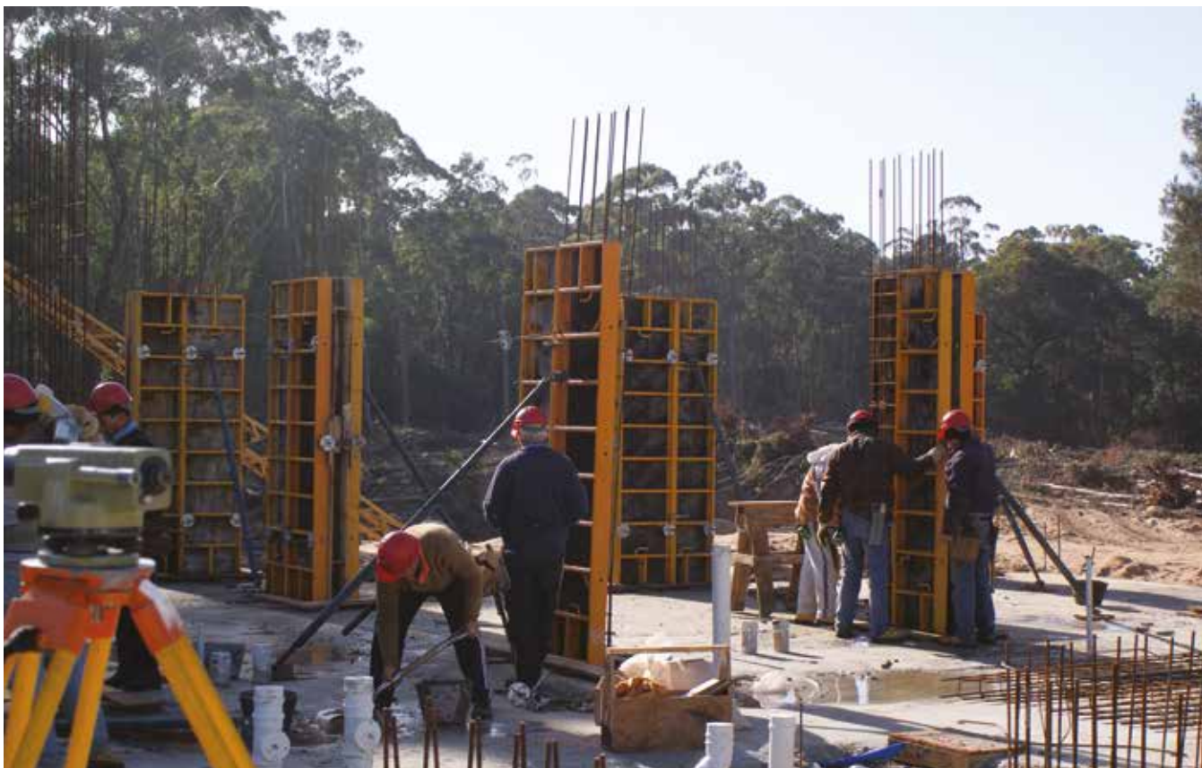
Ampliación del club privado Green Park dentro del Solanas Vacation Club de Punta del Este. Encofrado de muros y pilares con Paneles ATK60 . Empresa Constructora: Alvaro Palenga.
