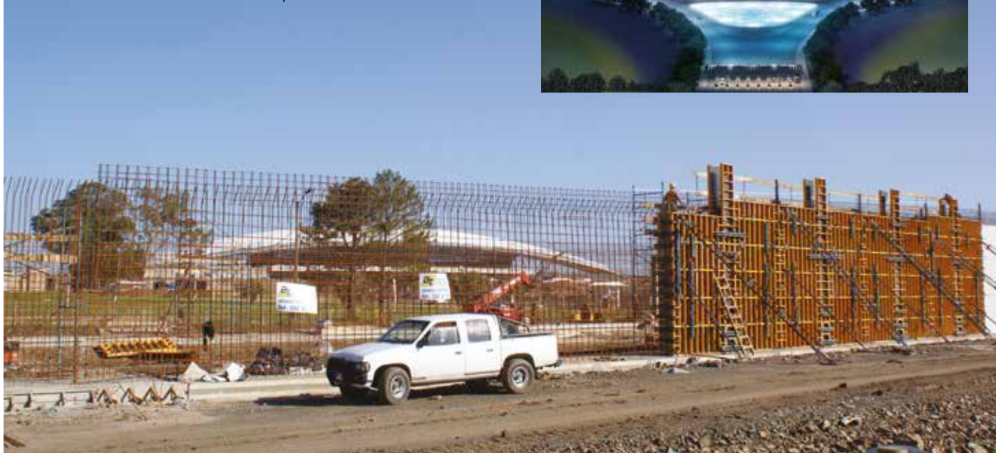
Muro de contención en los accesos al Aeropuerto Internacional de Carrasco
