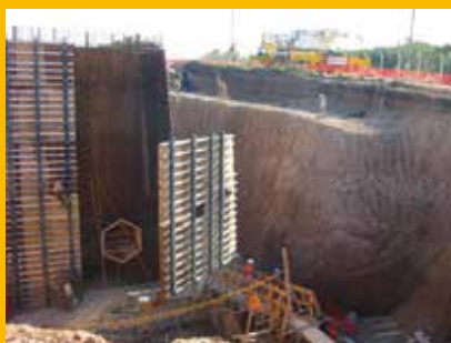
Pantallas con Vigas de Aluminio AT y Puntales Estabilizadores y puntal estabilizador tipo Estrella en la obra de Agroland, Rocha
