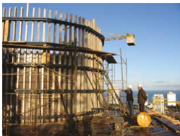
Vigas de Aluminio montadas en "costillones" para encofrar muros circulares. Edificio Torre 360, Punta del Este. / Empresa Constructora: Schutz - Borruzo
