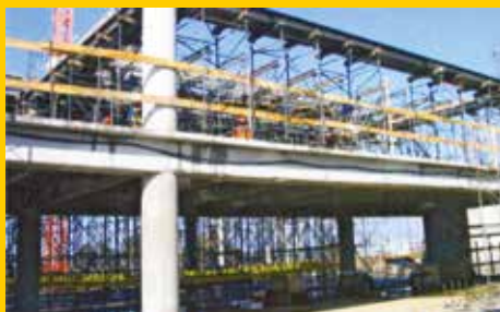
Edificio Torre Agua, Punta del Este
