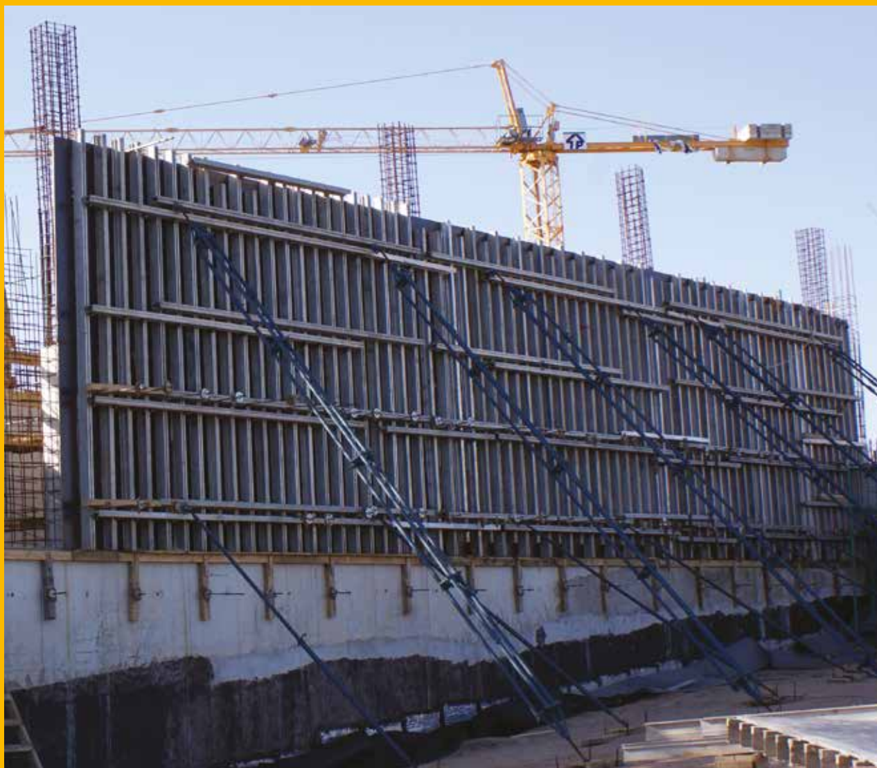
Pantallas con Vigas de Aluminio AT y Puntales Estabilizadores y puntal estabilizador tipo Estrella en la obra de Agroland, Rocha
