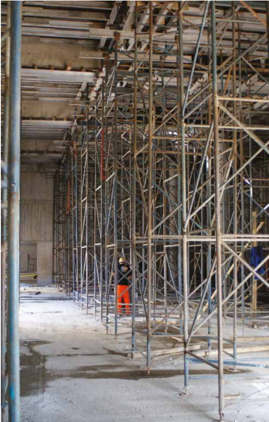
Tower AT como bloque homogéneo de apuntalamiento
