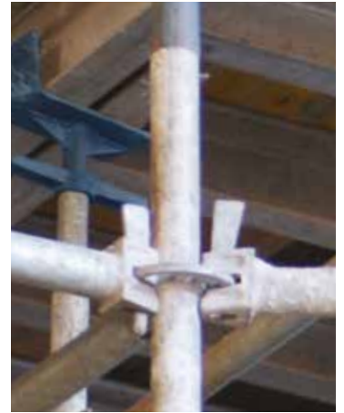
MDS apuntalando con Viga de Aluminio AT
