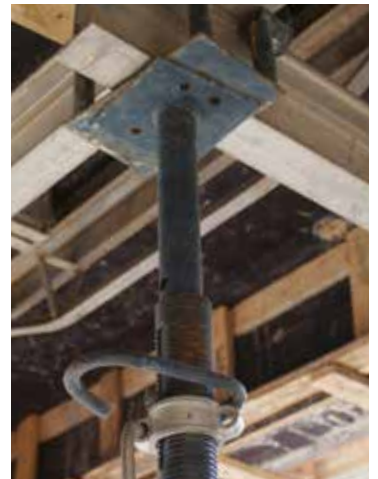
PuntalAT con viga de aluminio encofrando fondos de losas
