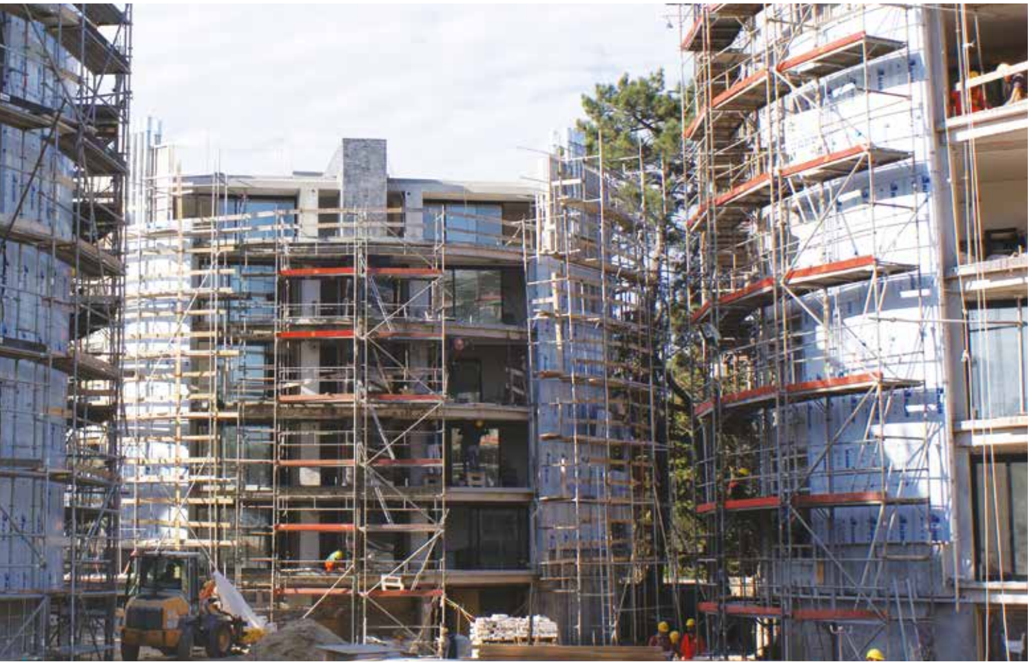
Edificio Loop en Parque Miramar, del Estudio Gomez Platero. El Sistema debió acoplarse al diseño circular del proyecto
